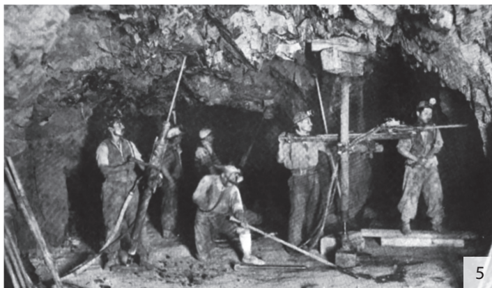
Foto 5: Perforistas en el interior de una mina. Véase la contradicción notable entre la tecnología de punta y la nula seguridad industrial: sombreros y gorros en lugar de cascos, pañuelos en lugar de filtros tipo “pulmosan”, zapatos normales en lugar de zapatos con punta de fierro. (ca.) 1920. (Oporto, 2007)
